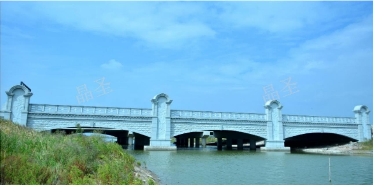
桥梁景观装饰栏杆的种类都有哪些？1、纵向设置的护栏分为路基护栏和桥梁护栏两种。2、横向设置的可分为路侧护栏和中间护栏两种。3、根据撞击后的护栏的变形程度分为柔性护栏、半刚护栏与刚性护栏三种。4、根据护栏的使用位置可分为桥侧护栏、桥中间隔离带护栏与行人、车道分界护栏。5、按照结构可分为梁式护栏和组合式护栏。桥梁栏杆的主要功能有防止车辆发生意外（防止车辆越出大桥的危险）和美化桥梁的作用。因为桥梁的样式很多和作用不一样，所以大家在选择护栏的时候一定要注意。我们需要综合的考虑安全性、协调性及需仿对象的特征、现场条件、防撞等级等。桥梁景观栏杆的作用是保护因事故而出桥的车辆或行人。南昌晶铸石桥梁整体装饰
